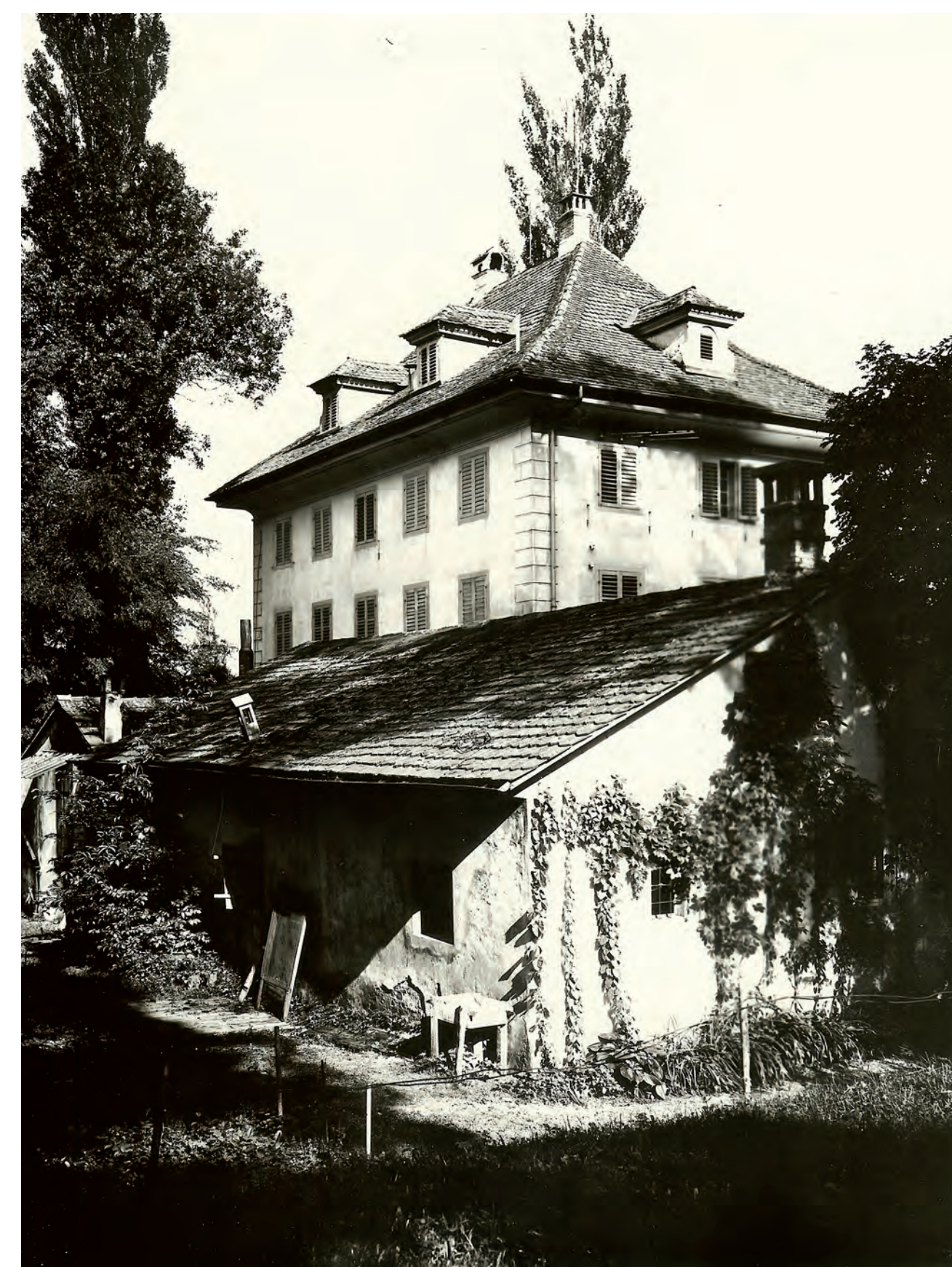
Ökonomiegebäude als Anbau zum Landhaus von Nordwesten, aufgenommen am 18.8.1930
