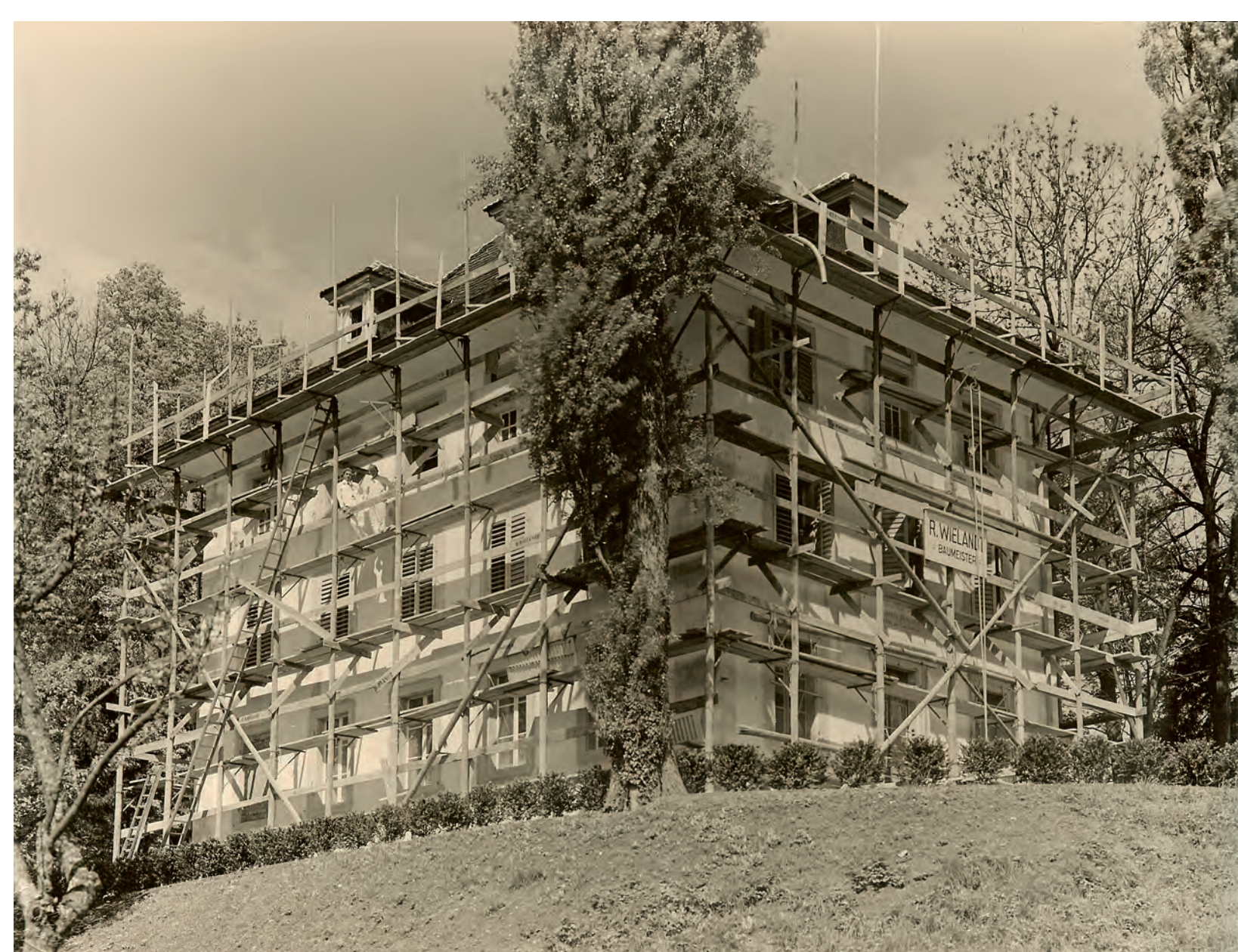
Haus mit Baugerüst, während der Sanierung, 1932
